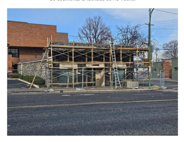
Este mes, las cuadrillas de trabajo comenzaron a desmontar y catalogar los bloques de la fachada delantera del edificio histórico AJ Tucker, que está ubicado en la esquina de NW Greenwood y NW Harriman en el centro de Bend.
